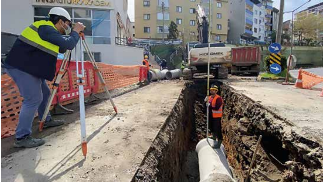
Yağmursuyu ve Kanalizasyon Hattı Ayırık Sistem Altyapı Çalışmaları
