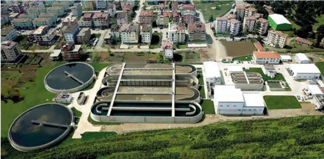
Ordu Atıksu Arıtma Tesisi
