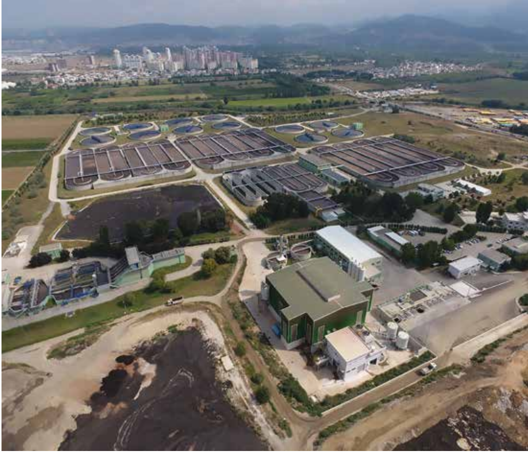
Doğu Atıksu Arıtma Tesisi
