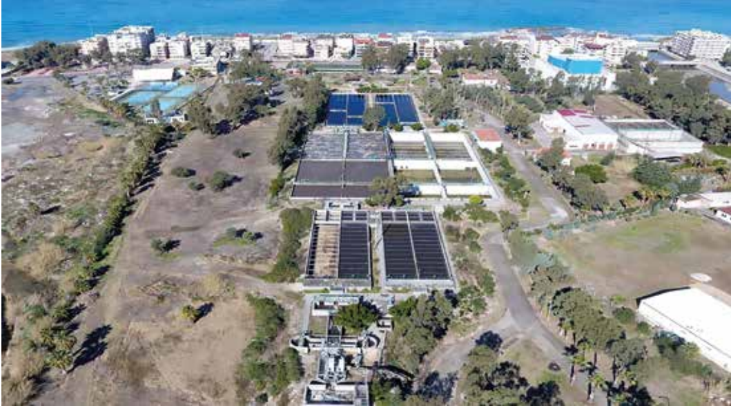
İskenderun Biyolojik Evsel Atıksu Arıtma Tesisi
