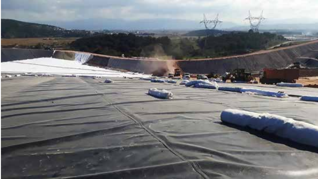
Sakarya Yeni Katı Atık Düzenli Depolama Sahası İnşaatı
