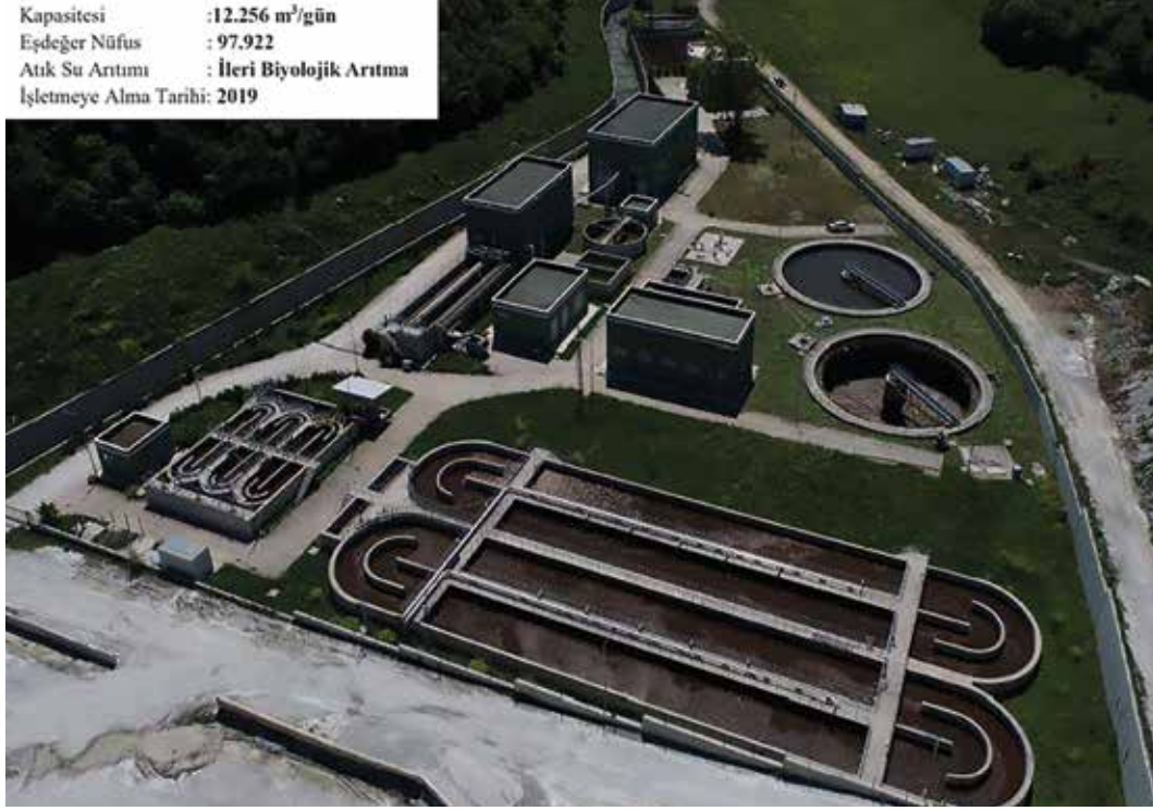
Samsun Batı İleri Biyolojik Atık Su Arıtma Tesisi
