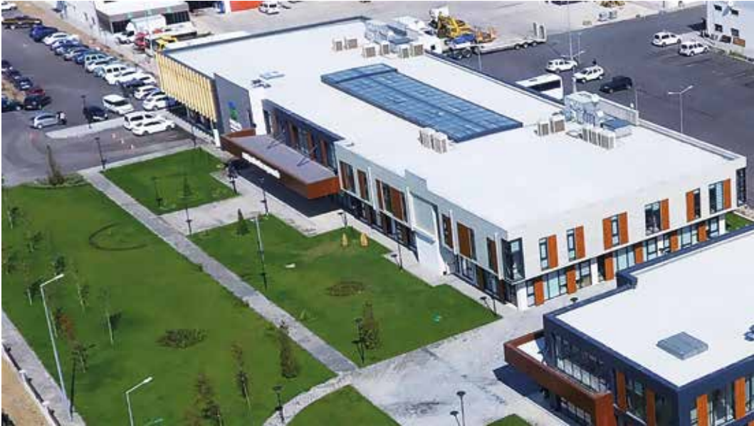
Fen İşleri Dairesi Çayırhisar Binası Çatı GES
