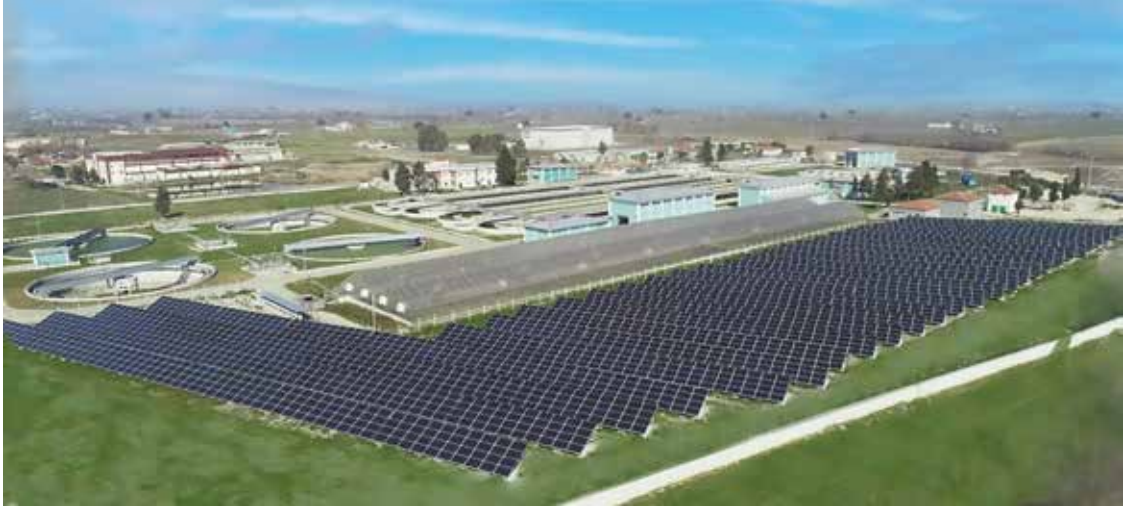
Manisa Atıksu Arıtma Tesisi Güneş Enerjisi Santrali
