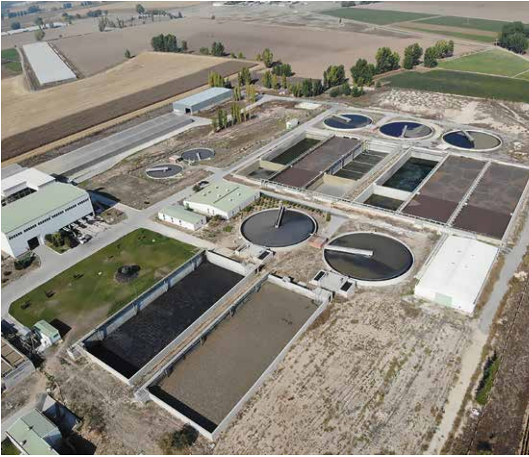
Eskişehir Organize Sanayi Bölgesi Atıksu Arıtma Tesisi
