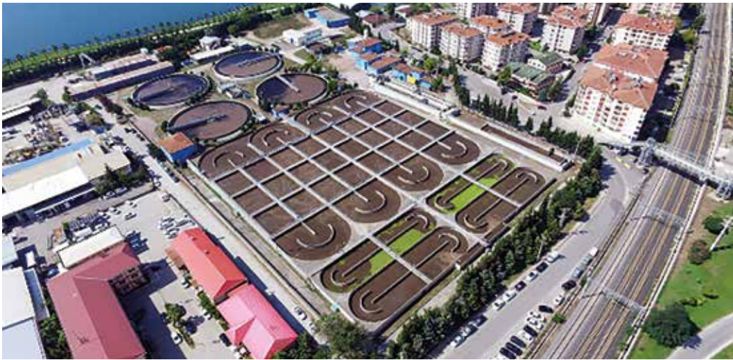
Gebze İleri Biyolojik Atıksu Arıtma Tesisi,
