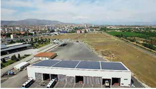
Trambus Bakım İstasyonu Güneş Enerji Santrali
