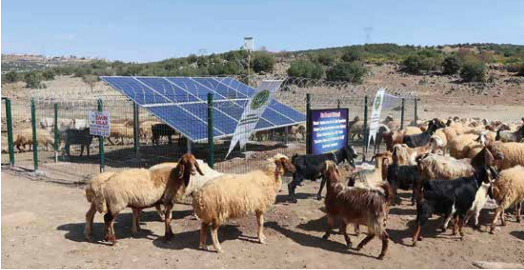
Meralarda Güneş Enerjisi ile Hayvan İçme Suyu Tesisi Projesi
