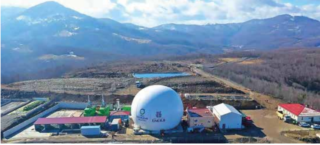
Katı Atık Depolama Tesisi Elektrik Üretim Altyapısı
