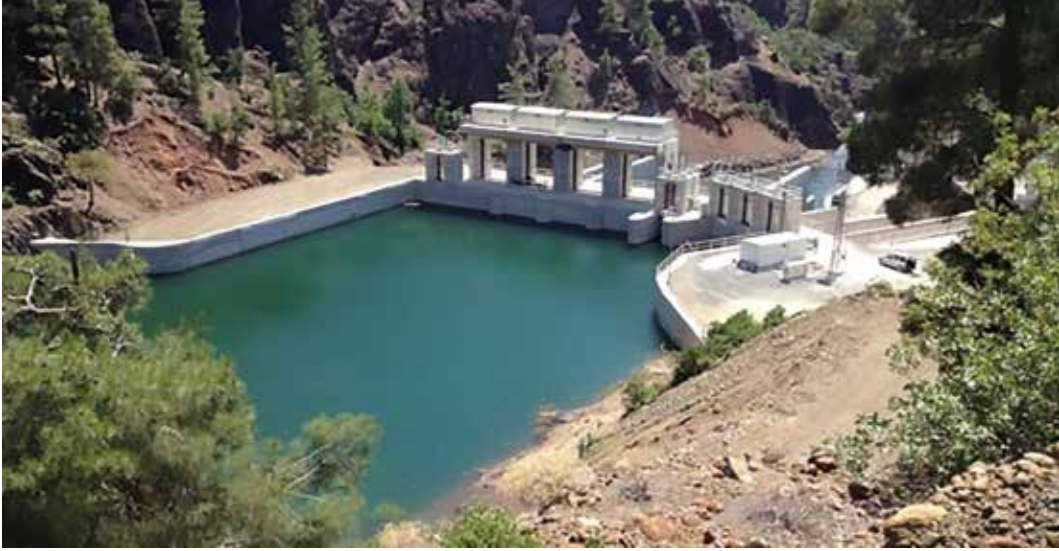
Akocak Hidroelektrik Santrali
