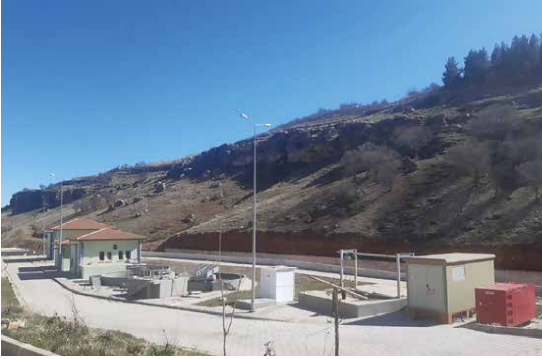
Eğil Atıksu Arıtma Tesisi
