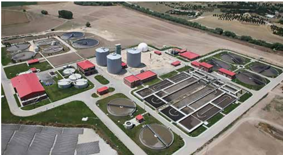
Eskişehir Atıksu Arıtma Tesisi
