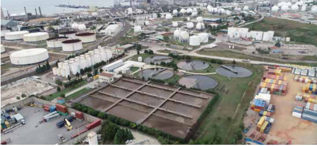
İzmit Plajyolu İleri Biyolojik Atıksu Arıtma Tesisi
