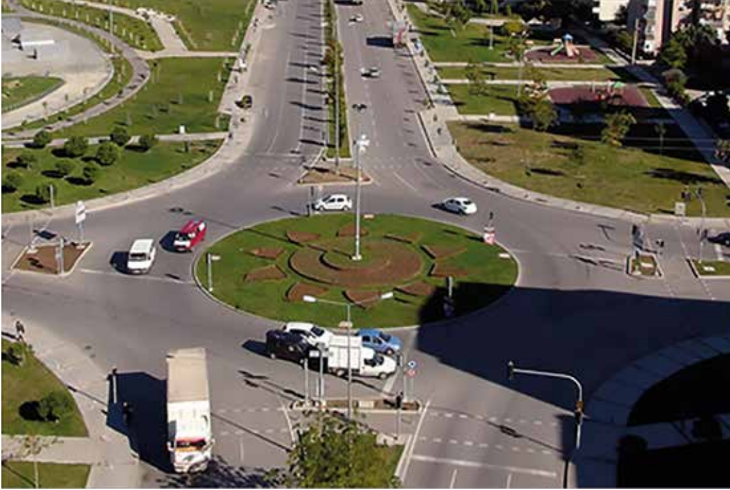
Diyarbakır Akıllı Kavşak Uygulaması
