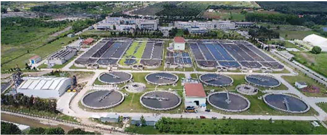
Körfez Atıksu Arıtma Tesisi
