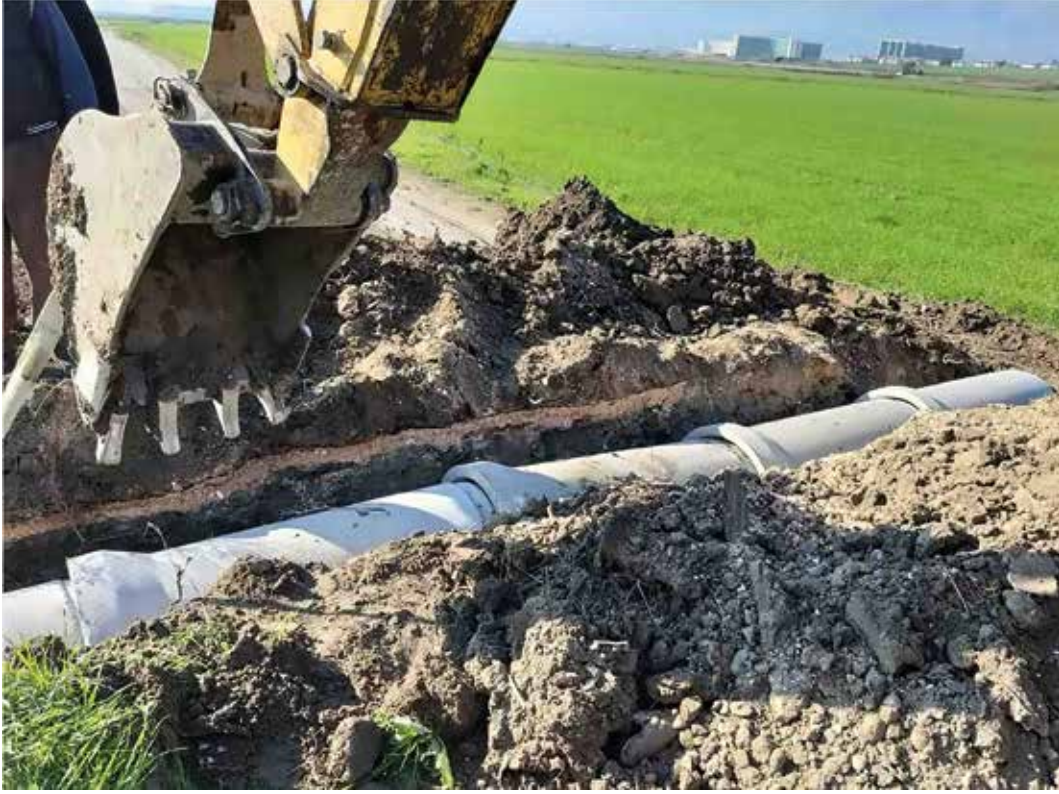
Alaaddin Mahallesi Yağmursuyu Hattı Çalışması
