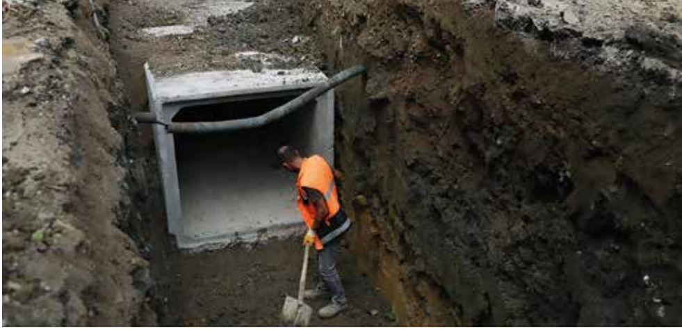
Ordu Büyükşehir Belediyesi Yağmursuyu Hattı Çalışmaları
