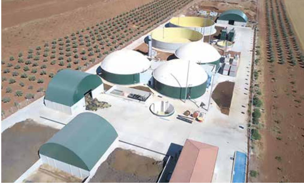
Oğuzeli Biyogaz Tesisi
