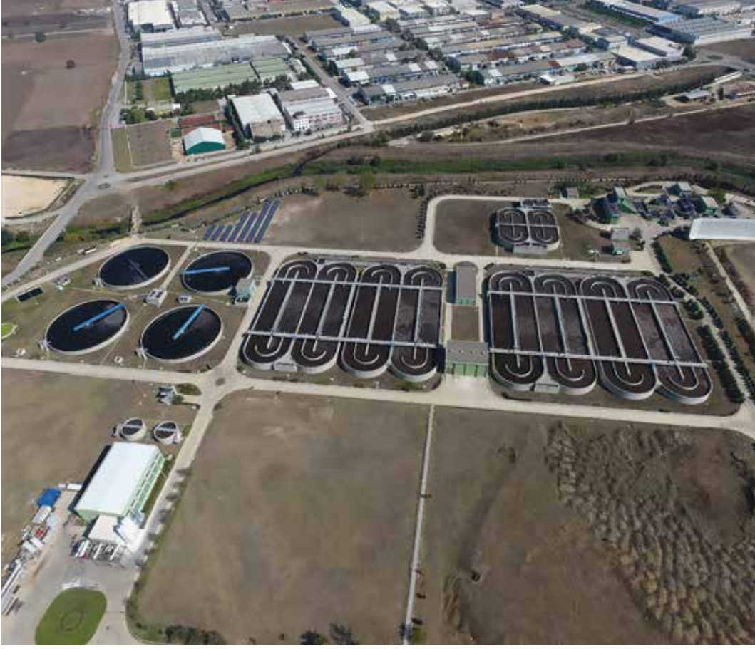
Batı Atıksu Arıtma Tesisi
