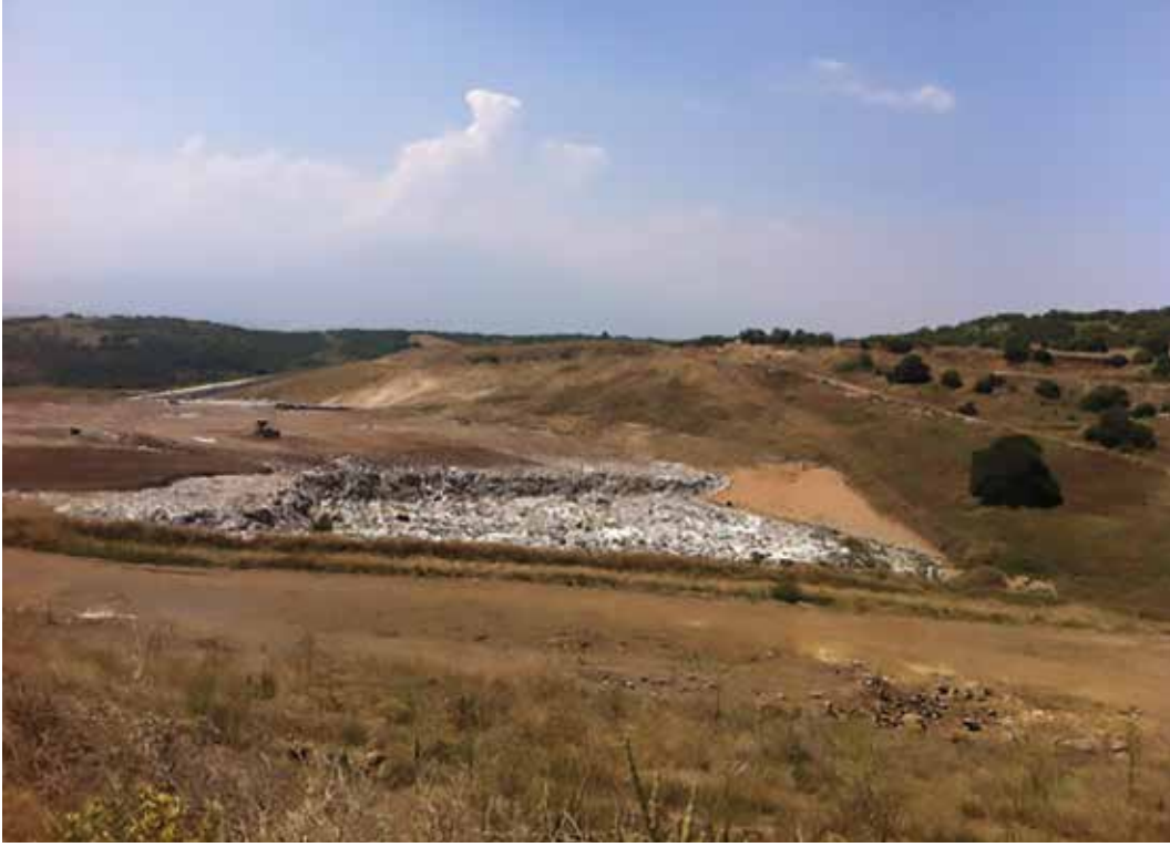
İnegöl Katı Atık Düzenli Depolama Alanı
