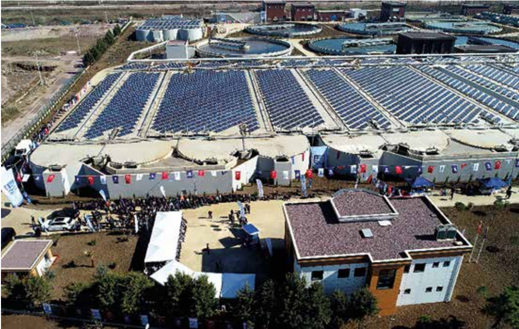
Kullar Atıksu Arıtma Tesisi Havalandırma Tanklarının Üzerine Yerleştirilen Güneş Enerjisi Santrali
