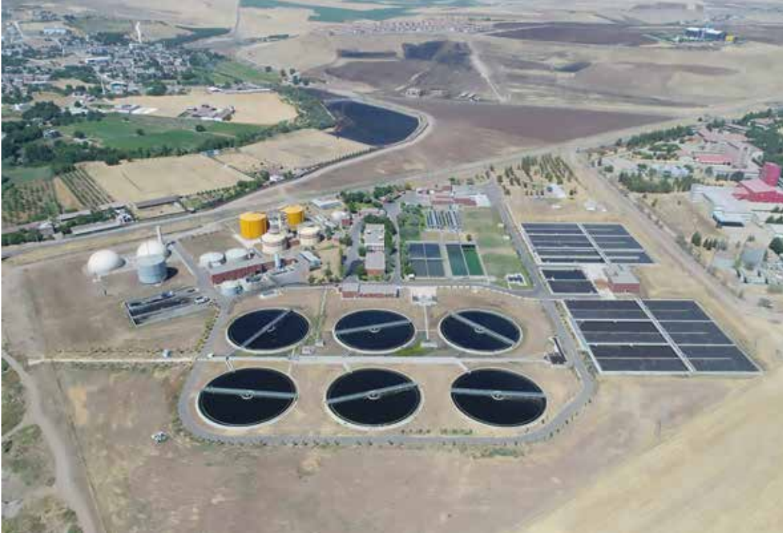
Diyarbakır İleri Biyolojik Arıtma Tesisi
