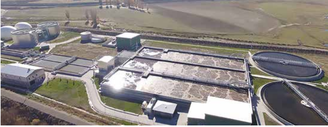
Erzurum Biyolojik Atıksu Arıtma Tesisi
