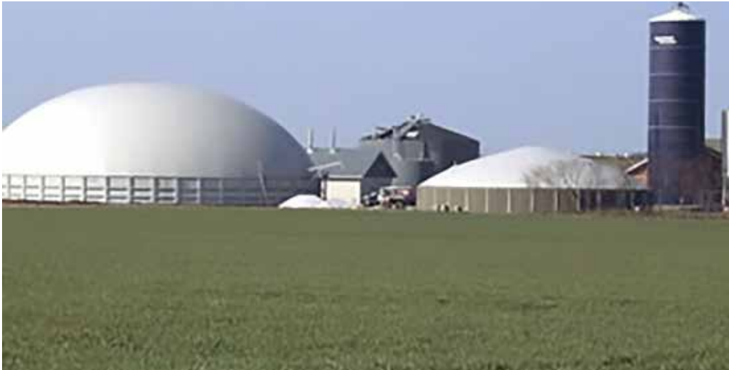
Samsun Avdan Biyogaz Elektrik Santrali
