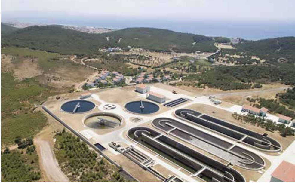
Ayvalık Küçükköy Atıksu Arıtma Tesisi
