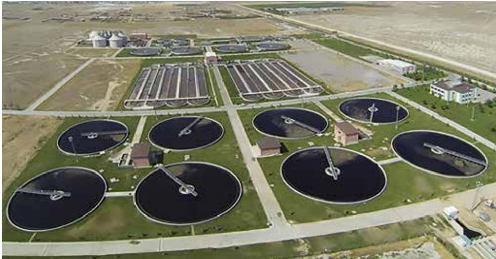
Atık Su Arıtma Tesisleri ve Atık Çamurundan Enerji Üretimi
