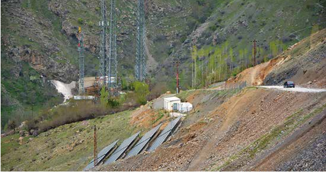
Çatak Belediyesi Güneş Enerjisi Santrali
