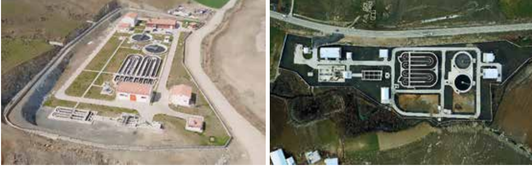
Kahramanmaraş İlinde Yer Alan Atıksu Arıtma Tesisleri
