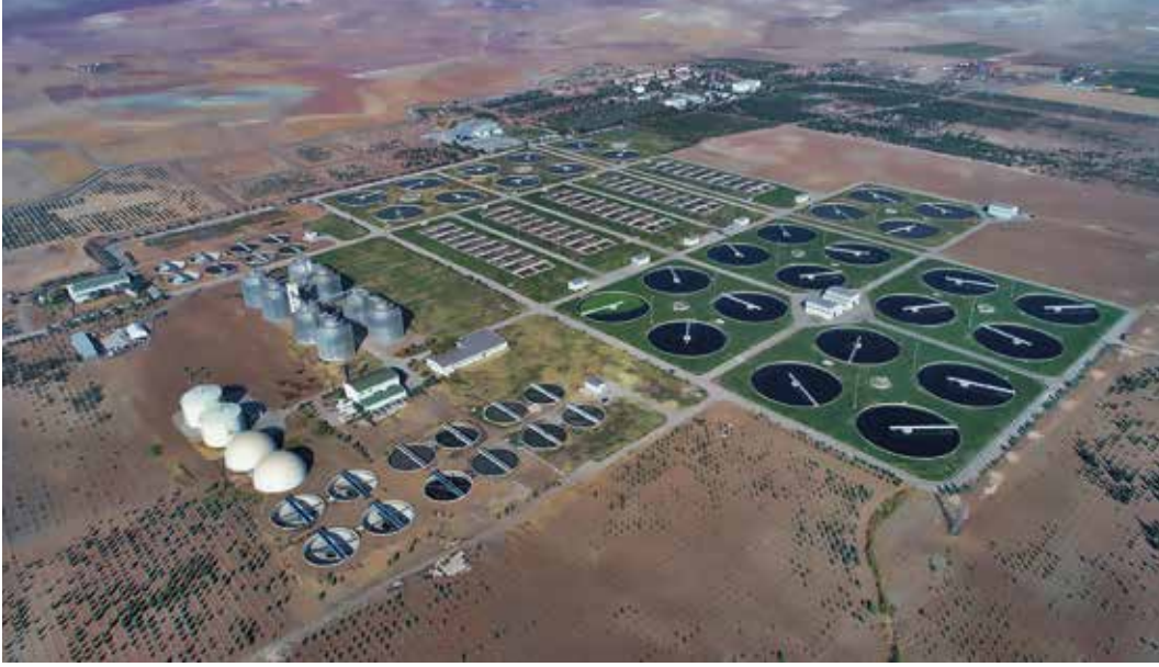
Ankara Merkezi Atıksu Arıtma Tesisi
