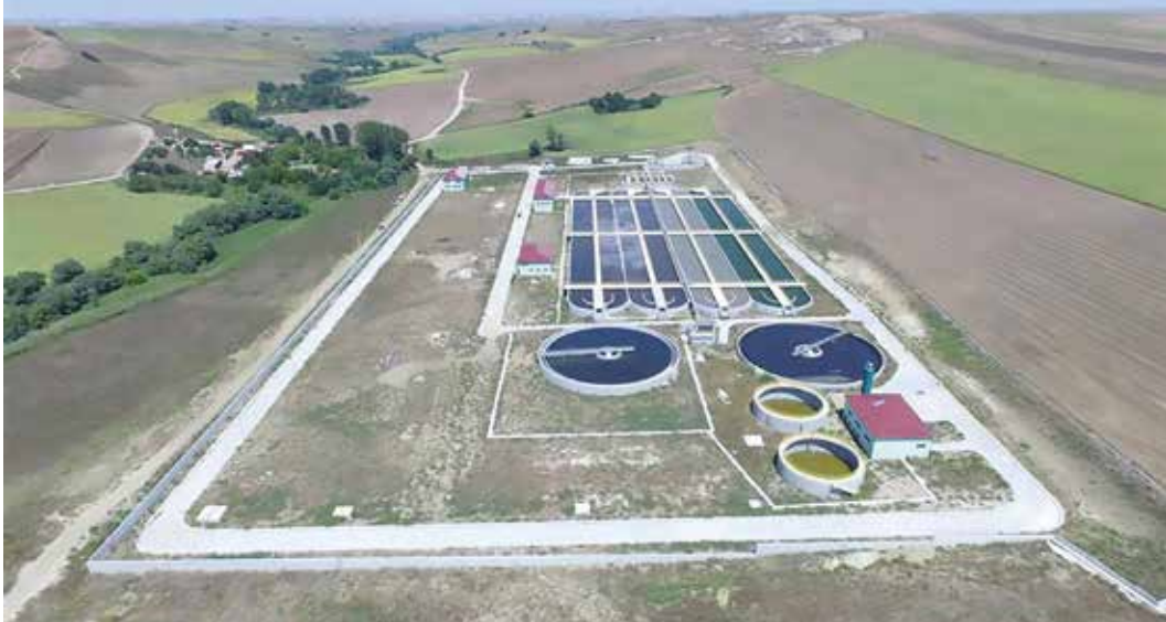
Çorlu Atıksu Arıtma Tesisi
