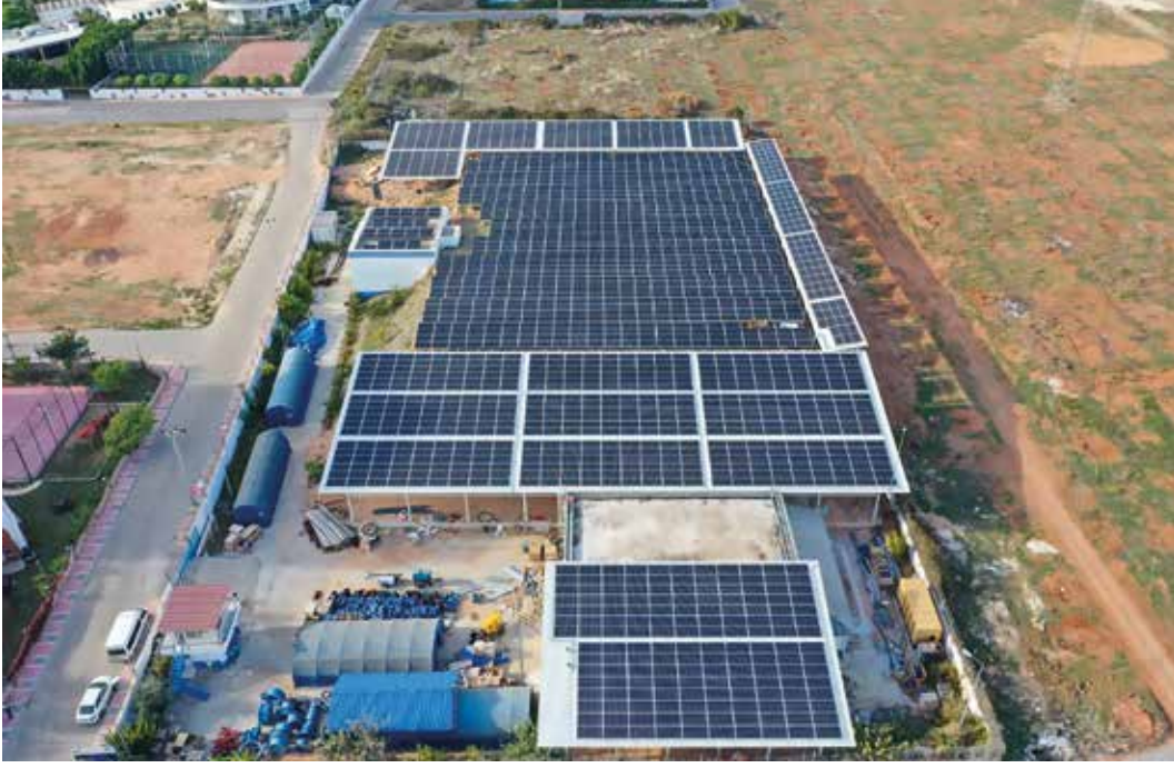
MESKİ Çatı Tipi Güneş Enerjisi Santrali
