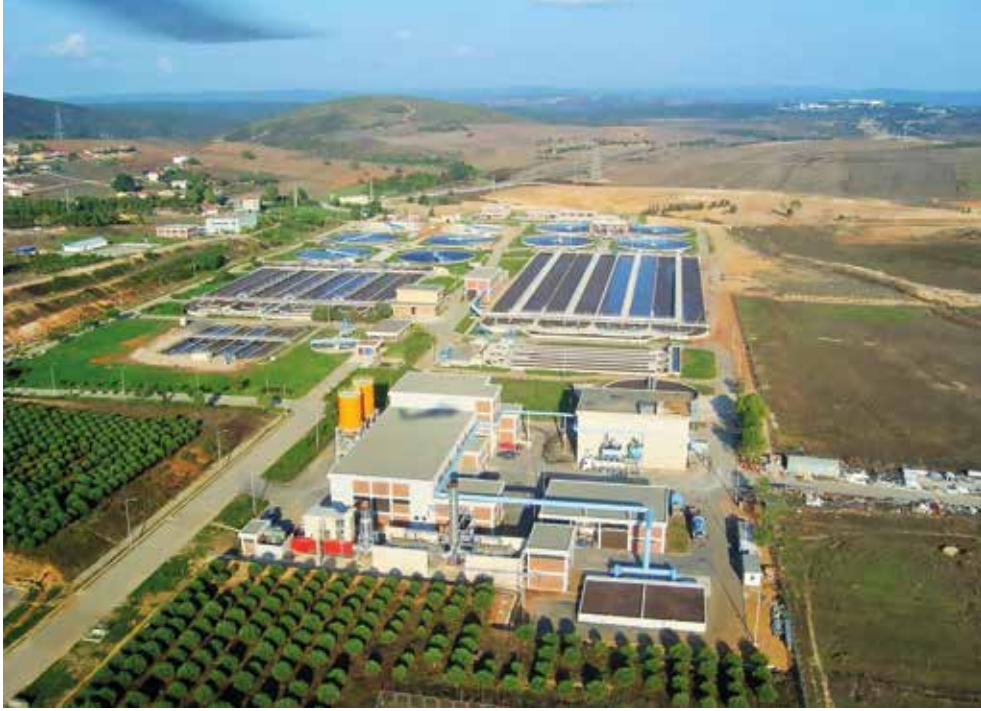
Paşaköy İleri Biyolojik Atıksu Arıtma Tesisi
