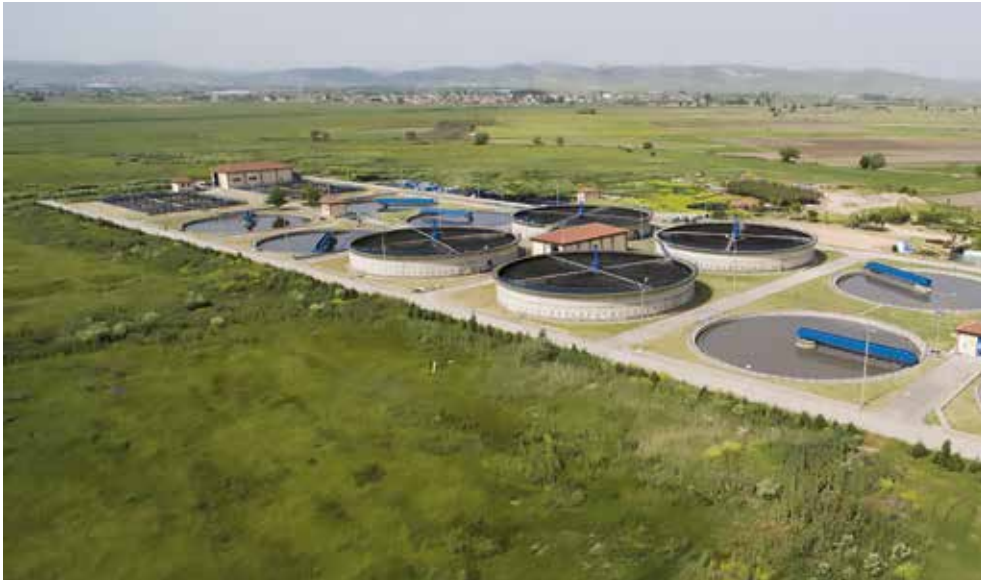
Balıkesir Merkez Atıksu Arıtma Tesisi
