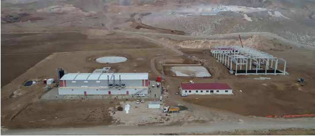
Van Entegre Katı Atık Tesisi
