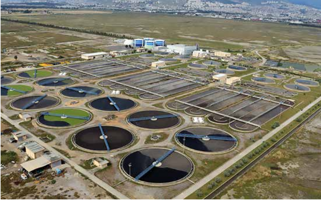
Çiğli Atıksu Arıtma Tesisi
