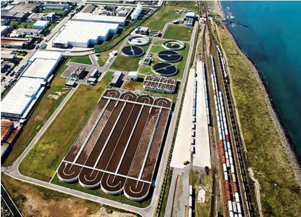
Samsun Doğu İleri Biyolojik Atıksu Arıtma Tesisi
