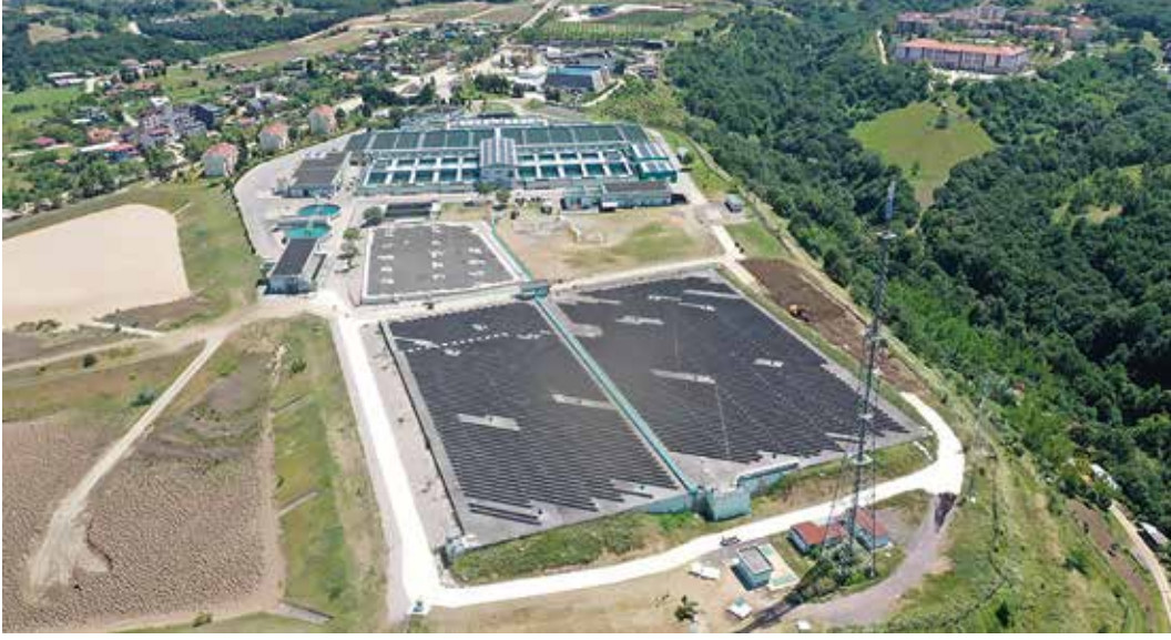
Yuvacık İçmesuyu Arıtma Tesisi Arazisine ve Bina Çatılarına Kurulan GES
