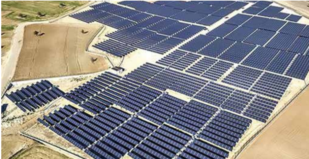
Bağlarbaşı Güneş Enerji Santrali
