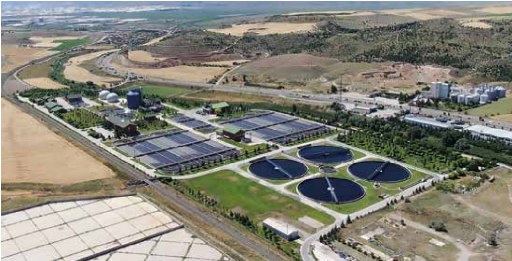
Kayseri İleri Biyolojik Atık Su Arıtma Tesisisi
