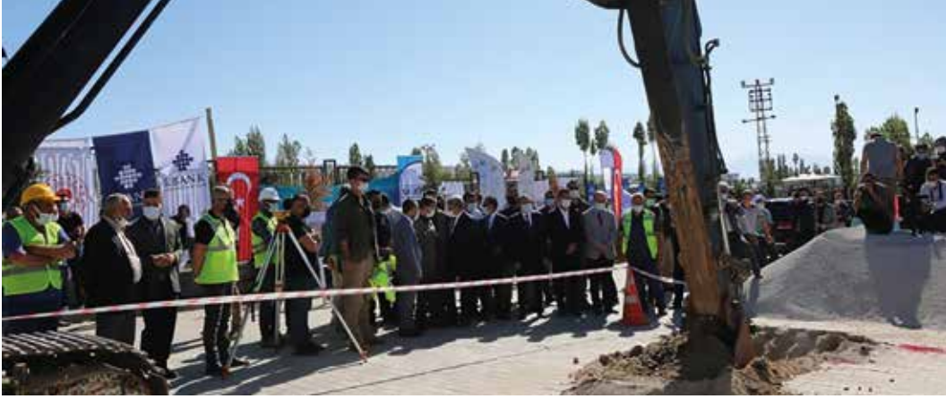
Van Edremit Kanalizasyon Hattı Çalışmaları
