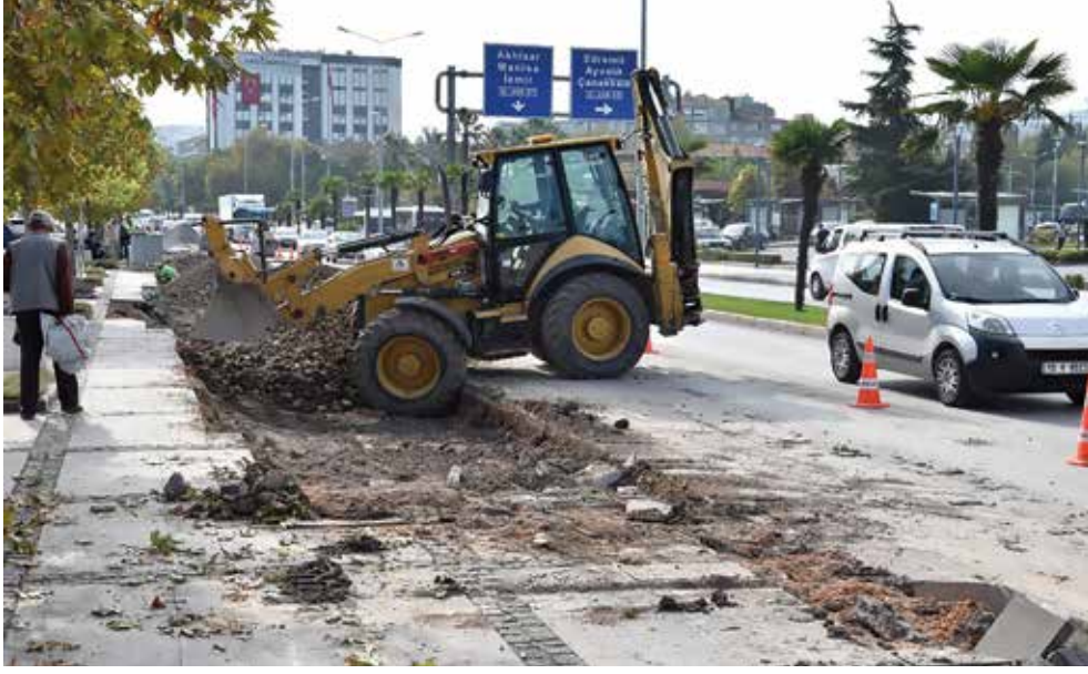
Vasıf Çınar Caddesi Altyapı Çalışmaları
