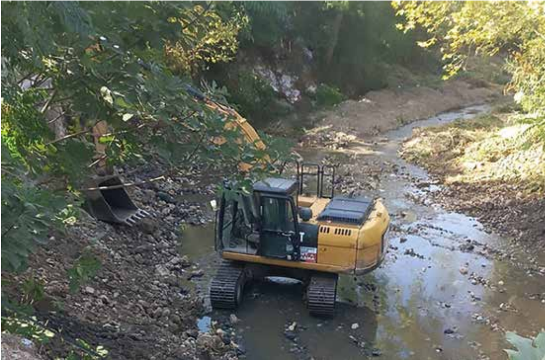
Dere Yatağı Temizleme Çalışmaları
