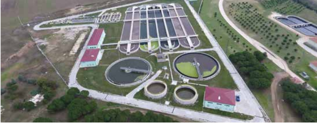
Çerkezköy-Kapaklı İleri Biyolojik Atıksu Arıtma Tesisi
