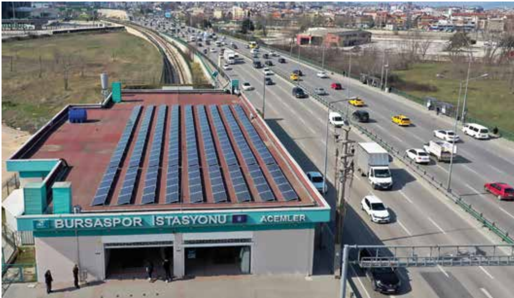
Acemler Metro İstasyonu Çatı Güneş Panelleri
