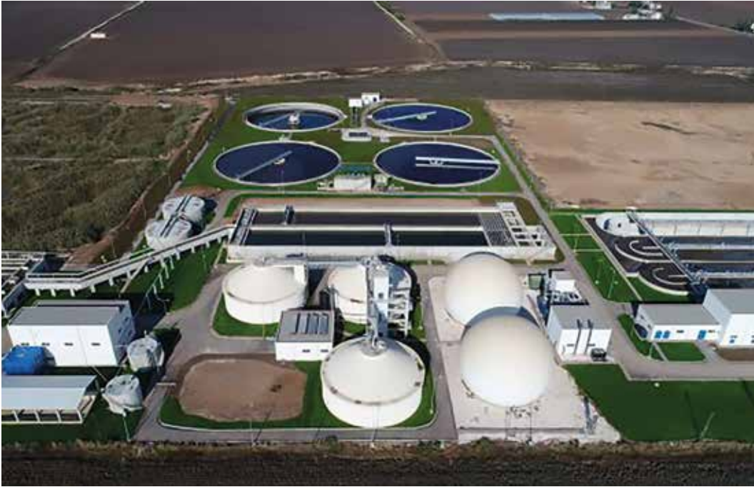
Şanlıurfa Merkez Atıksu Arıtma Tesisi
