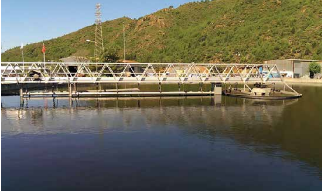
Marmaris İleri Biyolojik Atıksu Arıtma Tesisi
