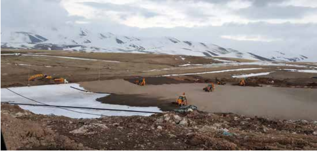
Erzurum Katı Atık Düzenli Depolama Sahası
