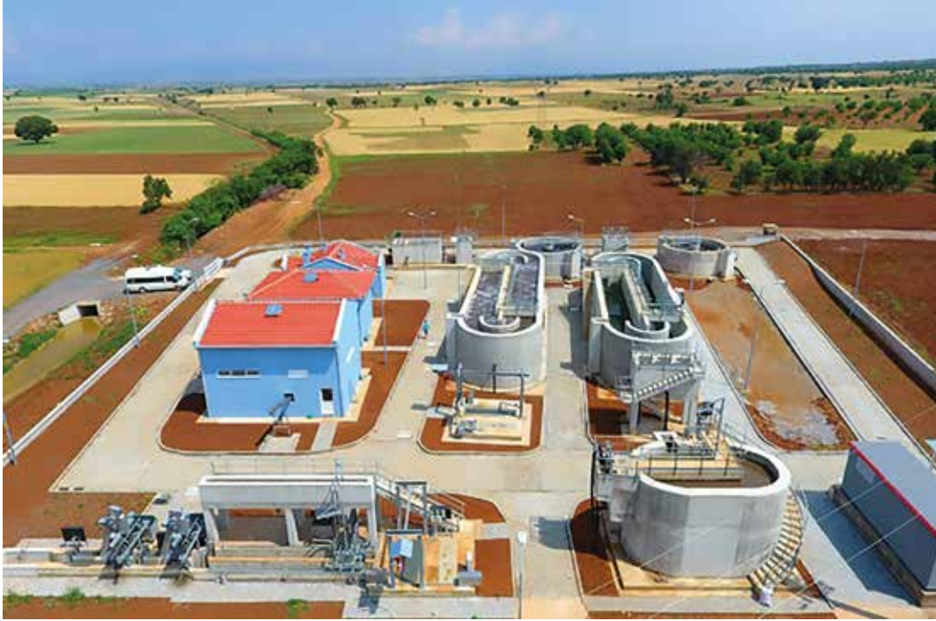
Denizli Baklan Merkez Atıksu Arıtma Tesisi
