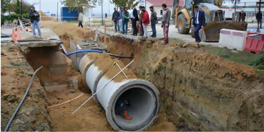
Hükümet Caddesi, Mimar Sinan Caddesi ve Atatürk Bulvarı'ndaki Çalışmalar Kapsamında Döşenen Yağmursuyu Hatları
