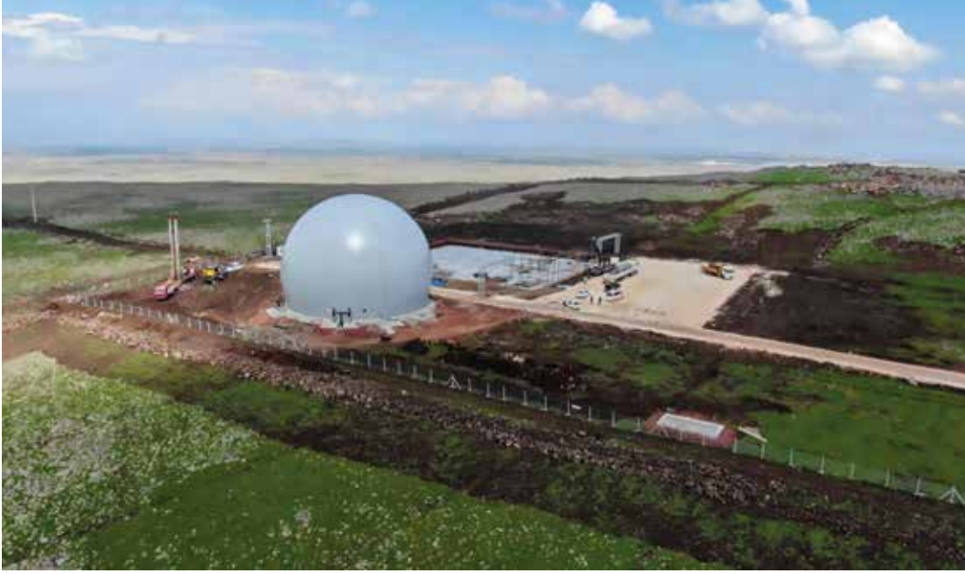
EKAY Karacadağ Çöp Depolama Sahası ve Enerji Üretim Tesisi
