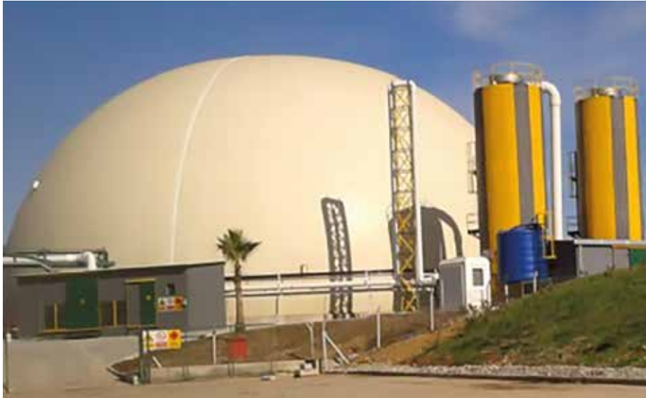
Adana Büyükşehir Belediyesi Entegre Katı Atık Bertaraf Tesisi / Gaz Depolama Balonu
