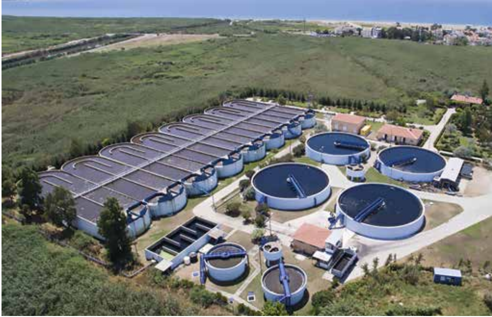
Edremit Zeytinli Atıksu Arıtma Tesisi
