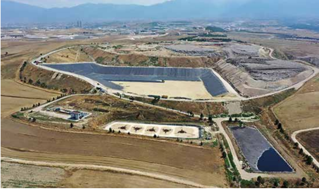
Denizli Kumkısıık Katı Atık Bertaraf Tesisi
