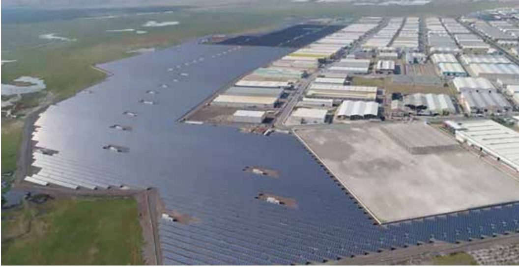
KOSB Güneş Enerjisi Santrali
