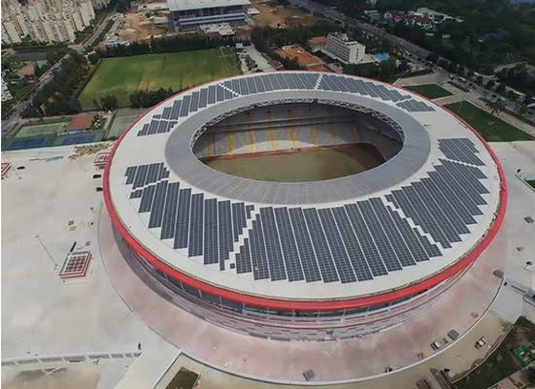
Antalya Stadyumu Güneş Enerjisi Santrali 10
